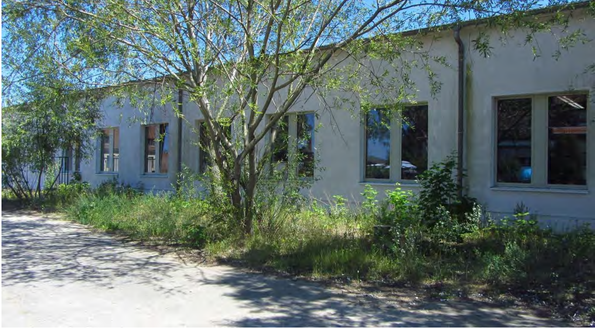
Abbildung 10: Grünstreifen vor dem nördlichen Gebäude der Hochschule mit Wildwuchs aus Pappeln und Weiden
