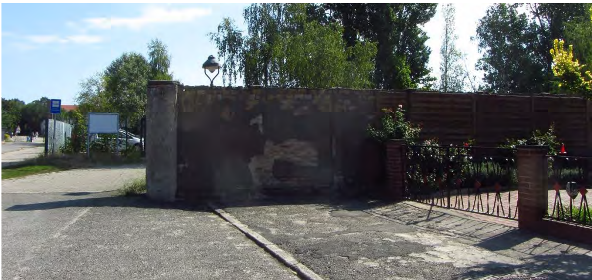
Abbildungen 7+8: Mauer an der Grundstücksgrenze Hans-von-Dohnanyi-Straße 15, Blick von Osten (oben), Blick von Westen mit Mauerabschnitt auf öffentlicher Fläche (unten)
